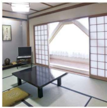
客室内鉄骨ブレース
